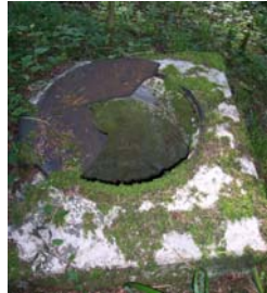
Defekte und undichte Brunnenstuben
