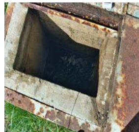
Defekte und undichte Brunnenstuben
