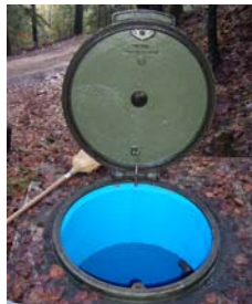
Betonbrunnenstube mit intaktem Schutzanstrich innen und aussen
